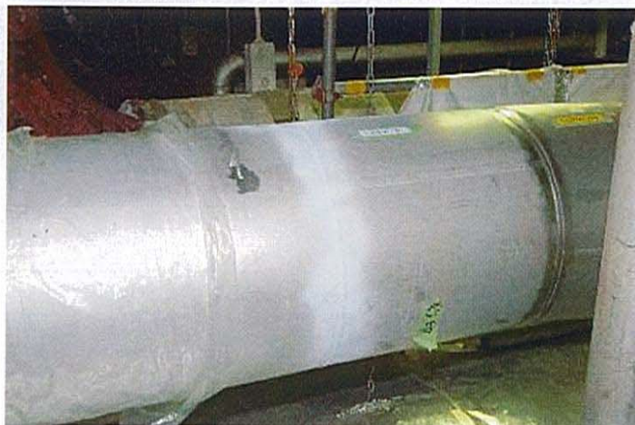
非破壊検査(PT)、溶接仕上がり検査
