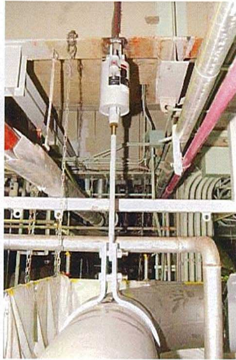
サポート取付け
