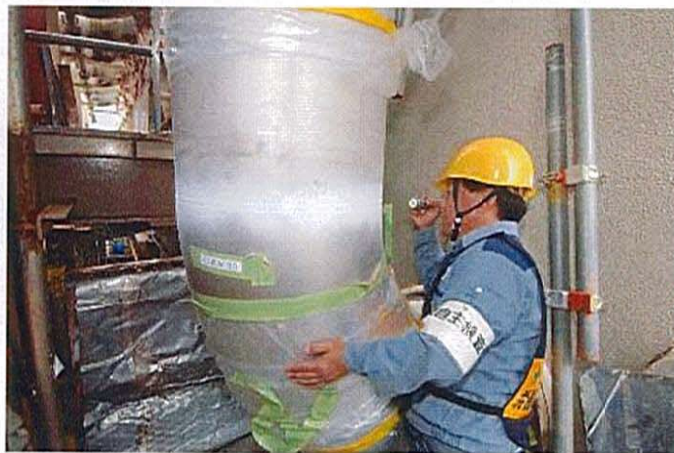
非破壊検査(PT)、溶接仕上がり検査
