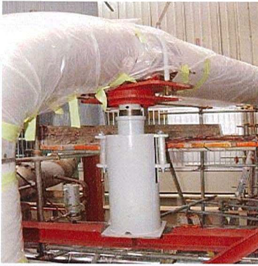
サポート取付け
