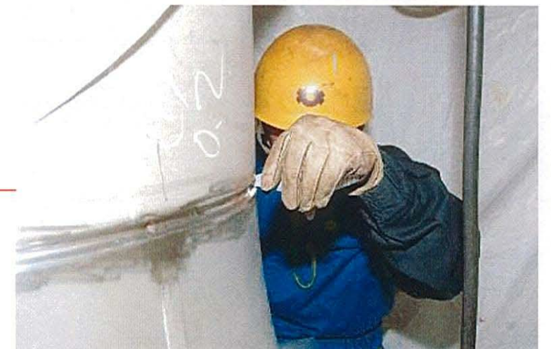
材料確認検査、開先検査
