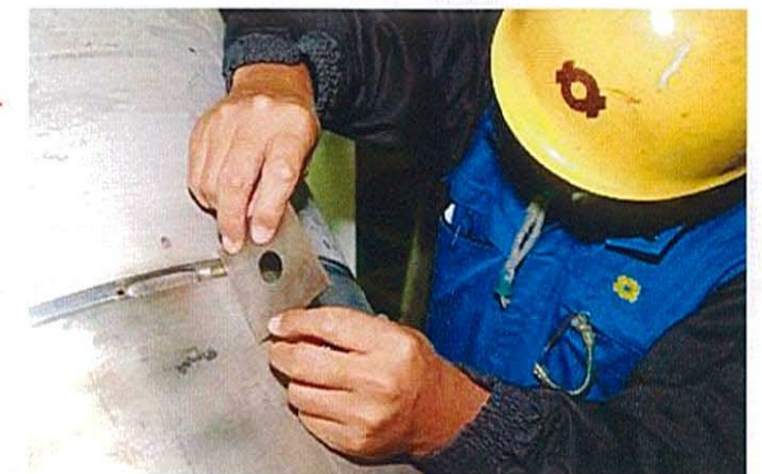
材料確認検査、開先検査
