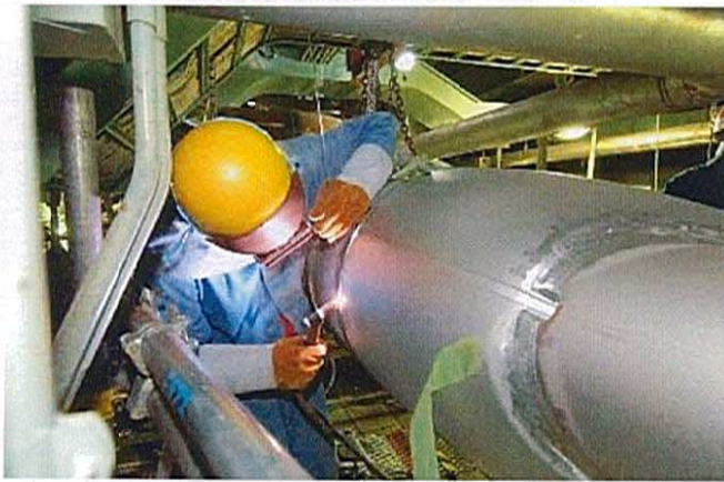
溶接、溶接ビード仕上げ
