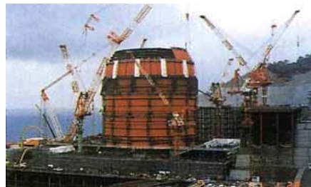
格納容器据付途中
