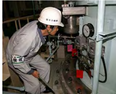
2次主循環ポンプ主モータ機能確認試験の様子
