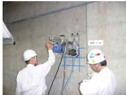
コアボーリングによる試料採取
