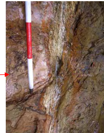
破碎帯拡大写真
