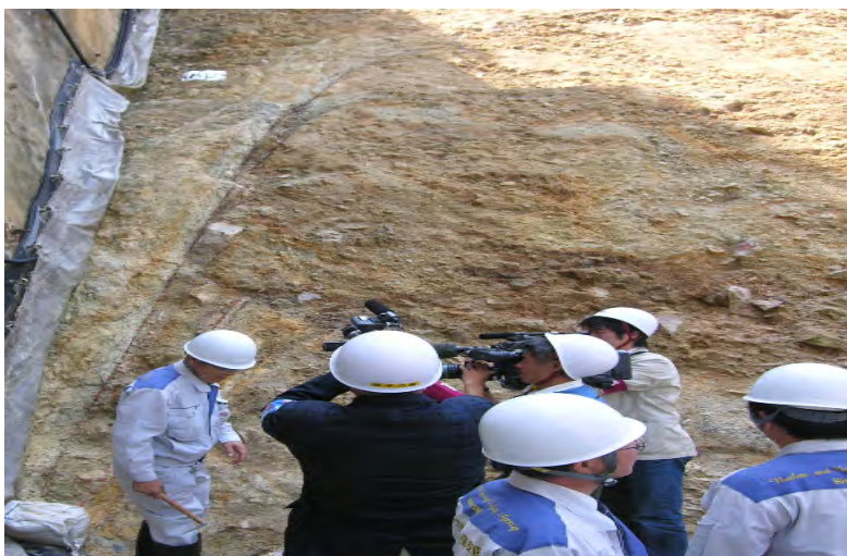
浦底断層Bトレンチ
