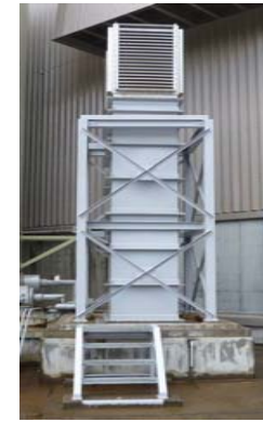
電動補助給水ポンプ室給気ダクト等の嵩上げ
