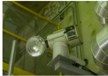
使用済燃料貯蔵池監視用 I T V (新規設置: 駆動電源は非常用電源系)
