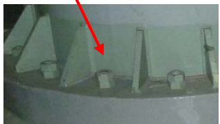
タンク基礎ボルト部
