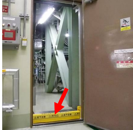
DG室浸水防止壁設置
