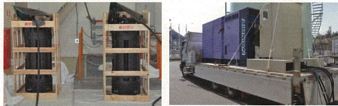
代替ポンプ(水中ポンプ2台) 水中ポンプ用発電機 補機冷却海水ポンプ代替ポンプの配備状況
