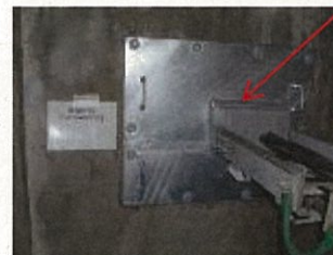
ケーブルダクト止水対策
