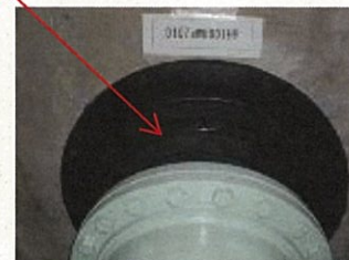
海水配管止水対策
