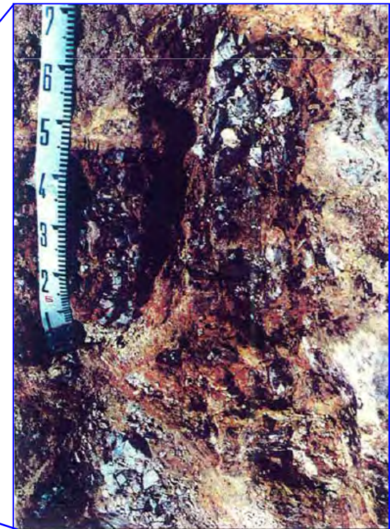
F-3破碎帯写真(開削箇所)
