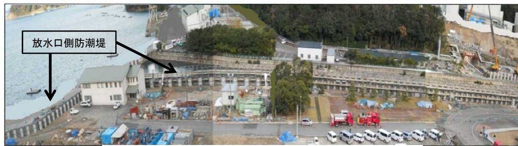
放水口側防潮堤
