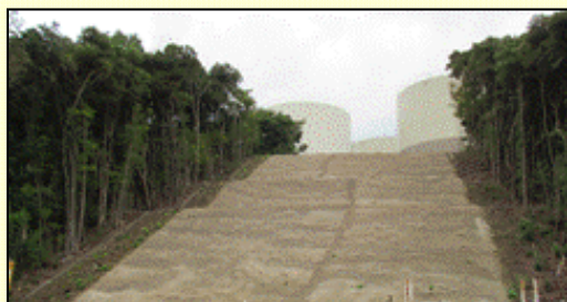
【防火帯設置後】
