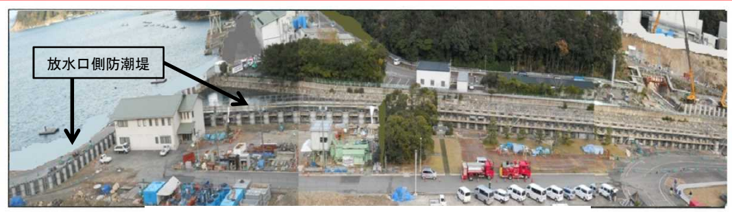
放水口側防潮堤
