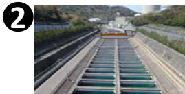
取水路防潮ゲート
