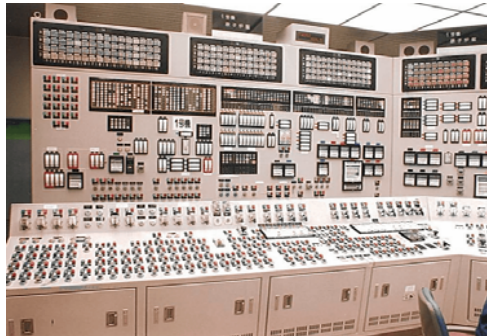
既設中央制御盤
