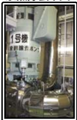
余熱除去ポンプ
