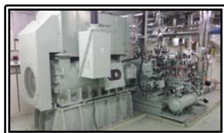
充てん・高圧注入ポンプ
