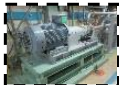
恒設代替低圧注水ポンプ (写真は高浜3,4号機)
