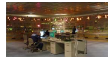
シミュレータ訓練 (非常灯照明下)
