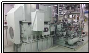
充てん・高圧注入ポンプ
