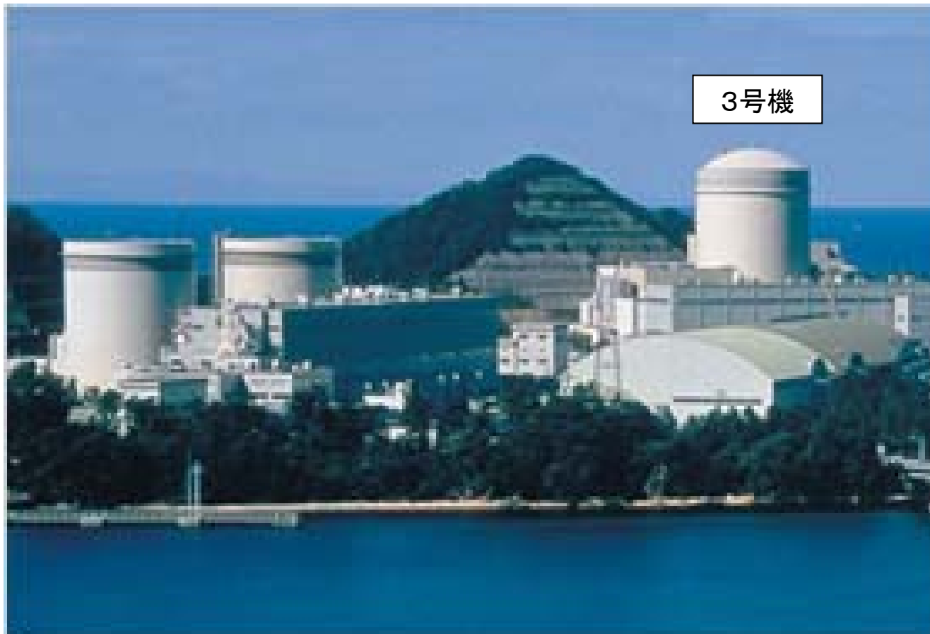
美浜発電所の景観
