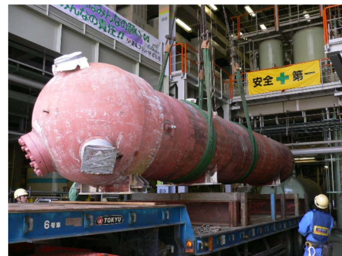
③ タービン建屋内機器解体 (平成29年度下期～) ※写真は過去の熱交換器取替工事
