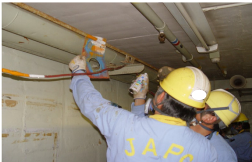
解体対象設備への識別作業
