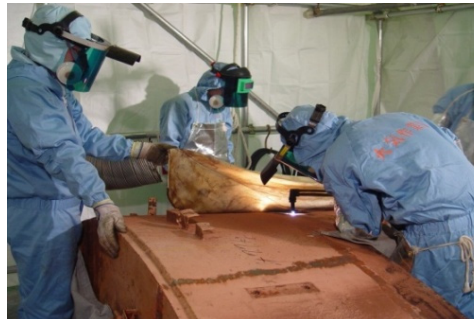
管理区域内での撤去物の細断作業
