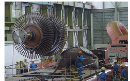
低圧タービンローター撤去作業
