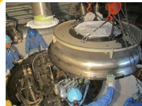
缶詰装置容器開放点検 （平成29年9月～）
