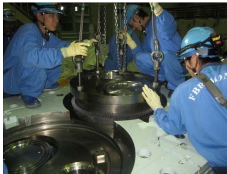
床ドアバルブ（6連式）の分解点検 （平成29年7月～10月）
