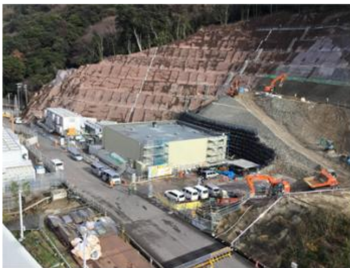
高浜発電所 緊急時対策所（全景）
