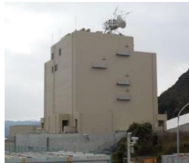
大飯発電所 免震事務棟 (全景)
