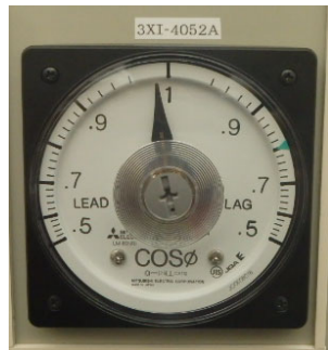
アナログ計器（中央制御室盤力率計）
