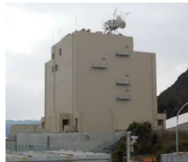
大飯発電所 免震事務棟 (全景)
