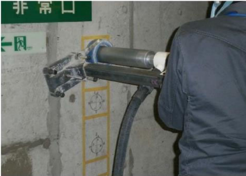
コンクリートコアサンプル採取状況
