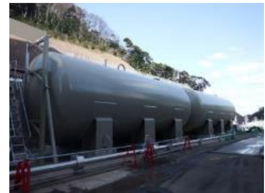
消火水バックアップタンク新設 (150m 3 ×4基/1・2号機)
