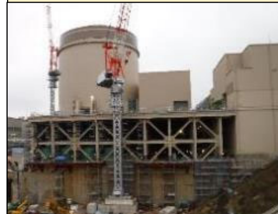
構台設置状況(2020.2)
