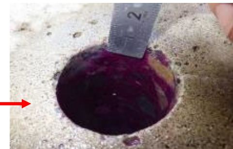
中性化深さの点検事例 (試薬により変色度合を確認)
