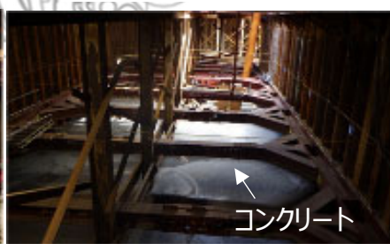
コンクリート打設の様子
