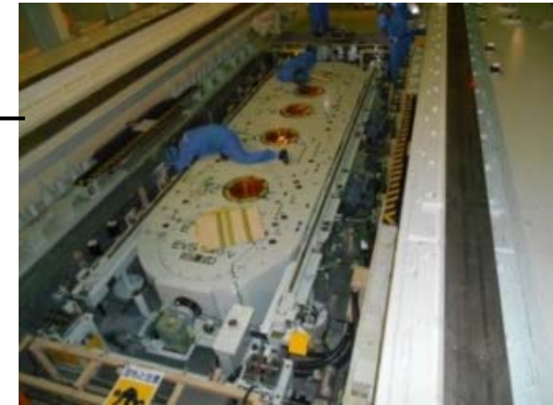
・床ドアバルブ（6連式）点検後の復旧作業状況
