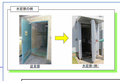
水密扉の例(四国電力HPより)
