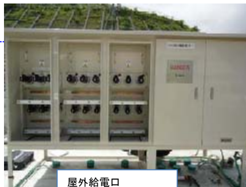
屋外給電口 （四国電力HPより）
